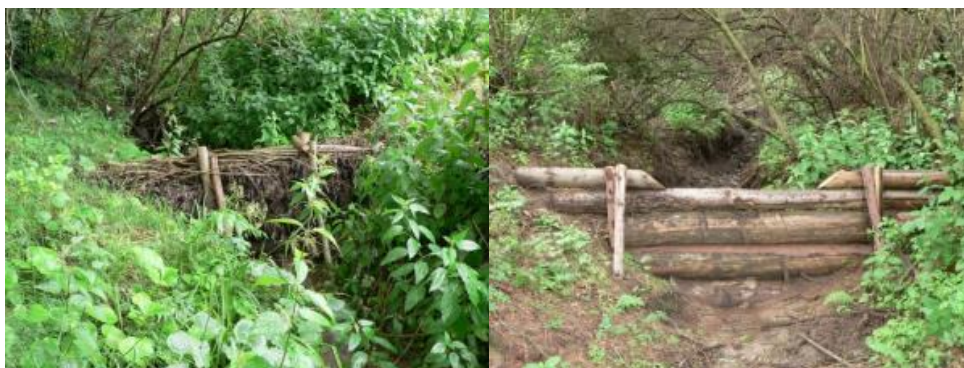
Fotodokumentácia zrealizovaných vodozádržných opatrení v povodí rieky Hornád nad priehradou Ružín
