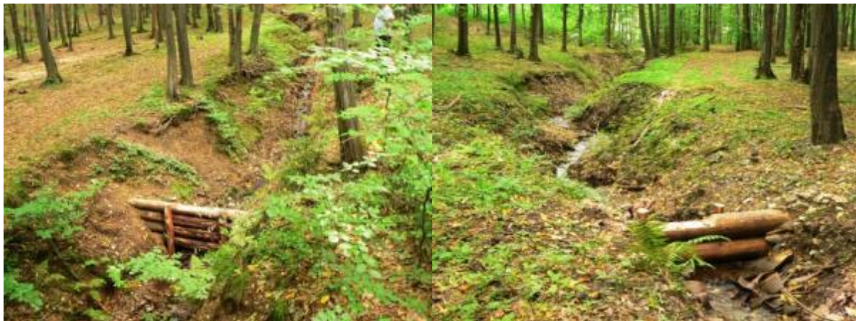
Vodozadržné opatrenia v katastri obce Gočovo, zrealizované v roku 2011
