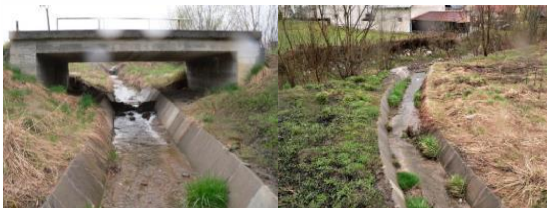
Uplatňovanie starej vodnej paradigmy na čo najrýchlejší odtok povodňovej vody do rieky Hornádu prispieva k zanášaniu priehradu Ružín
