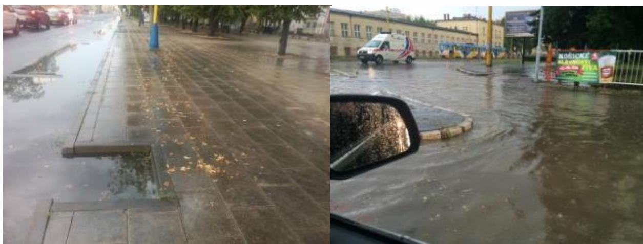
Manažment dažďovej vody Košice, Mojzesova ulica, 2010, Vojenská ulica 2014
